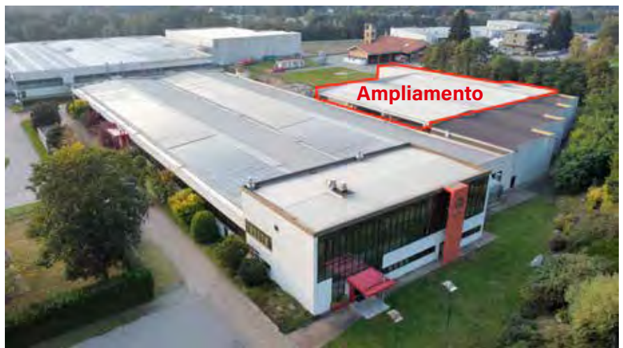
Vista aerea con il nuovo ampliamento
